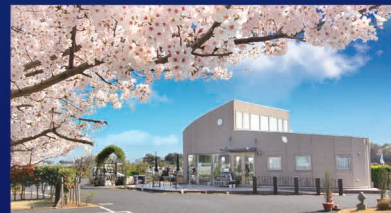
法要施設を完備し、管理人が常駐する管理棟
